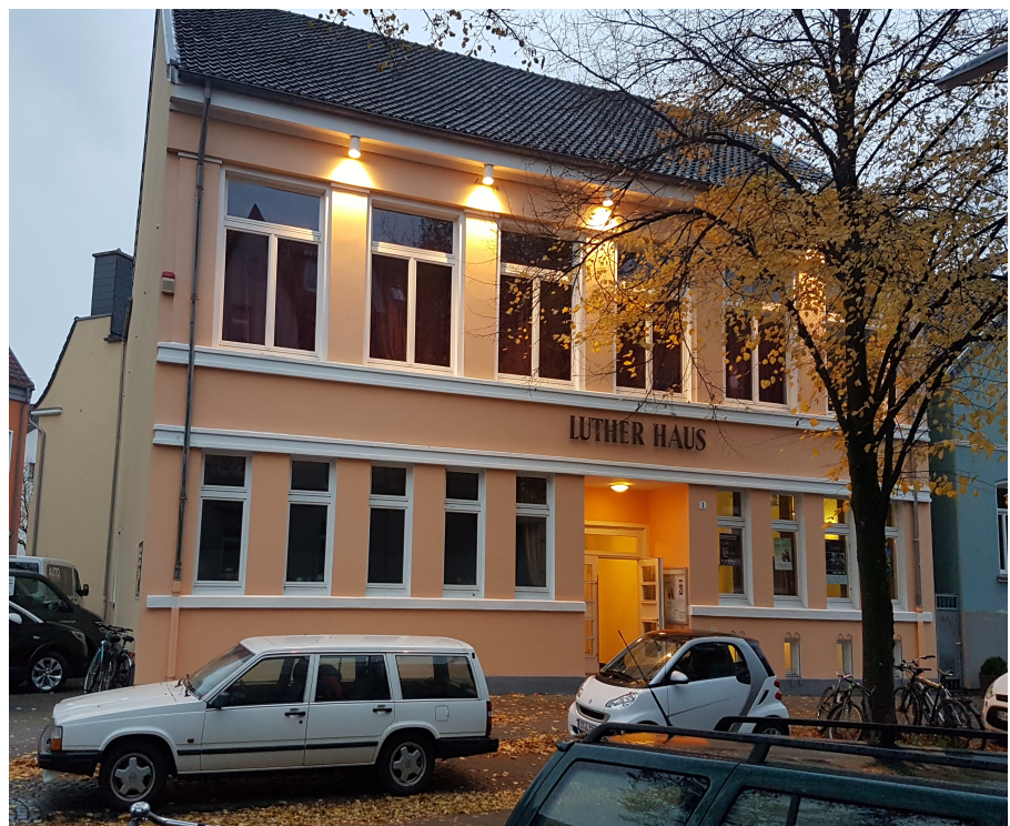
Lutherhaus heute (Foto: Jalda Guttzeit)
